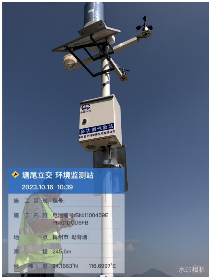
综合气象站安装照片
